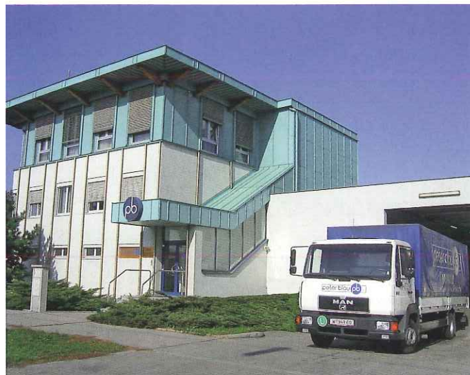
Bei der Firma Blau in Wien 23 sind alle Produktlinien von Sanha eingelagert, daher ist das gesamte Angebot sofort verfügbar.
